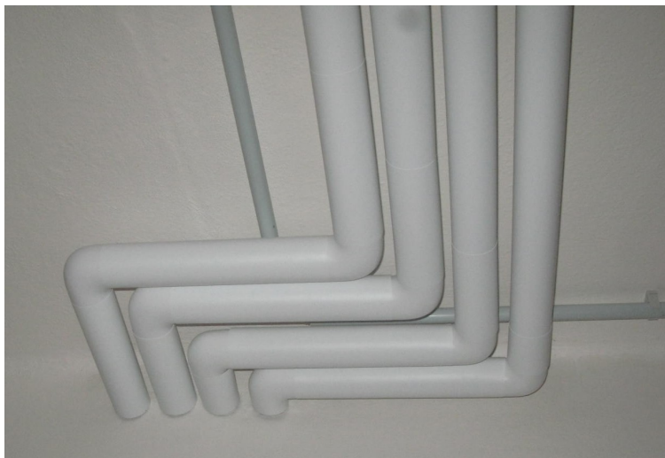
Obr. 1: Vzorové provedení tepelných izolací vedených mimo technické prostory, opatřených PVC folií
